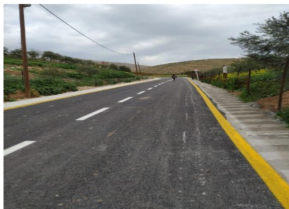
Part of Al- Ein Shebli internal Road
